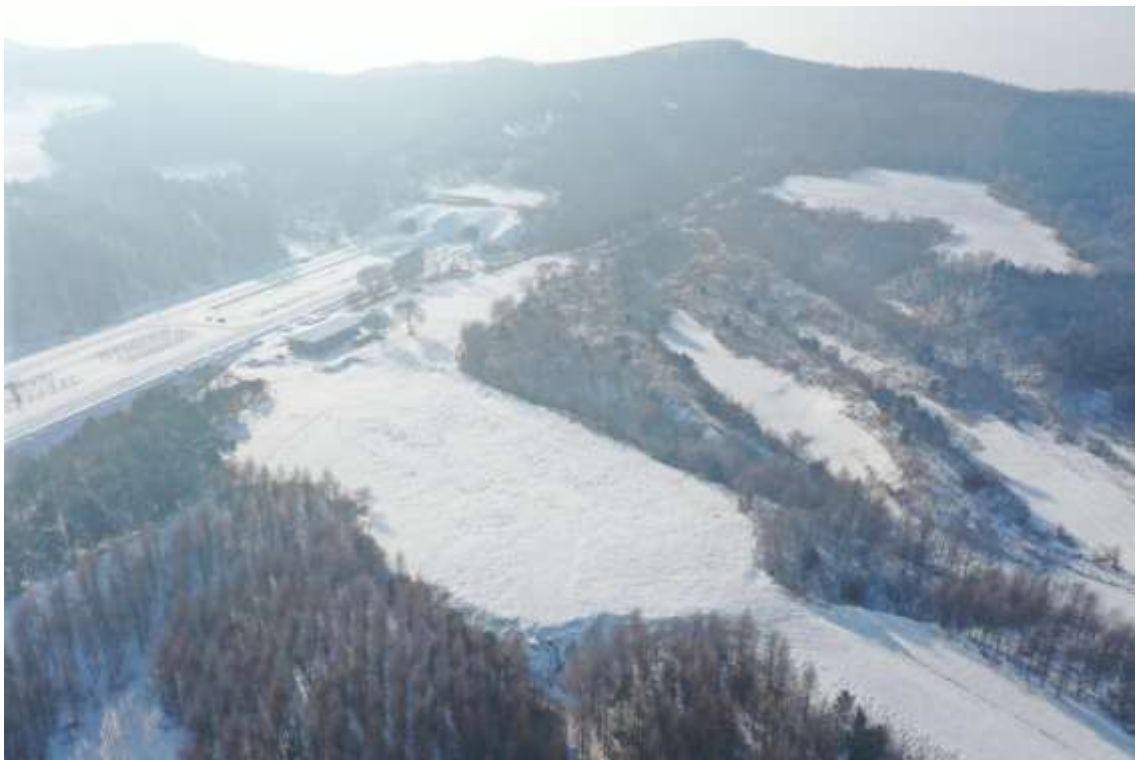
K166+100 施工营地
