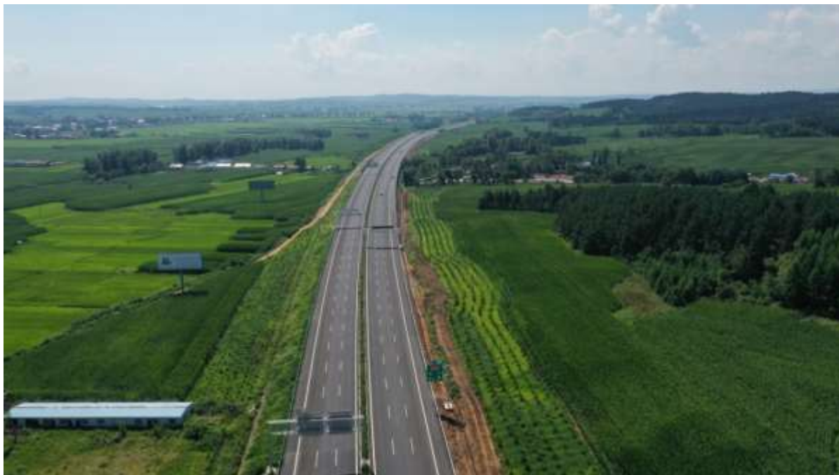
K100+000 主线左侧施工便道
