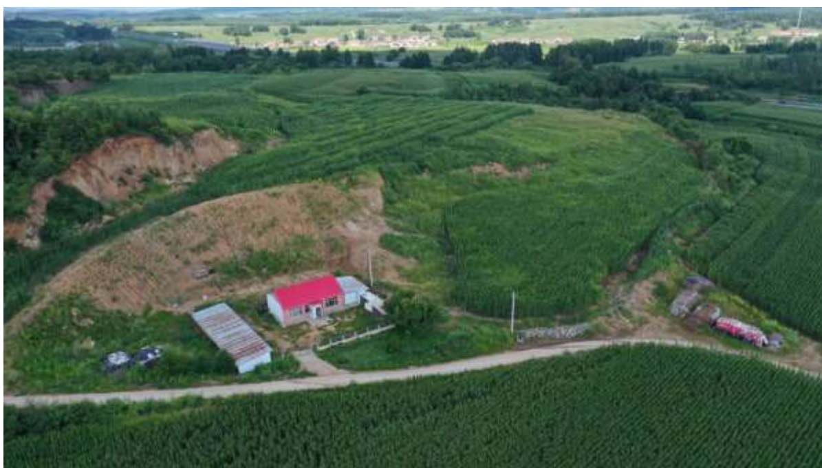
K108+460 弃渣场临近房屋
