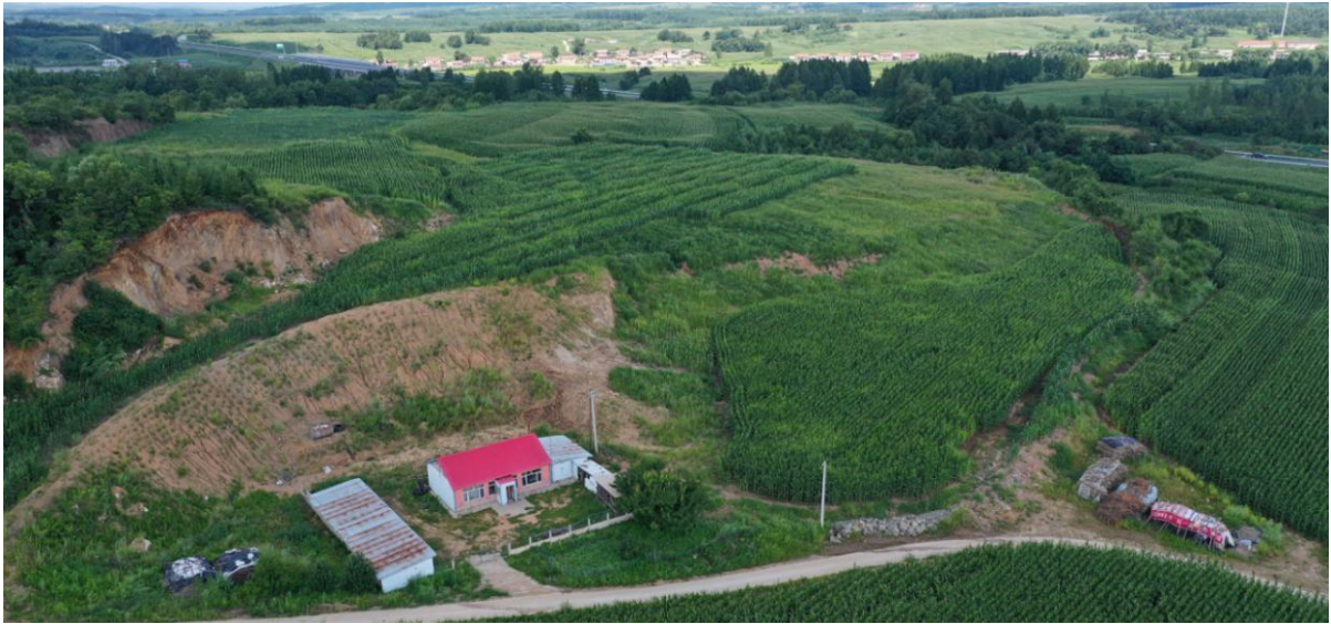
K108+460 弃渣场临近房屋
