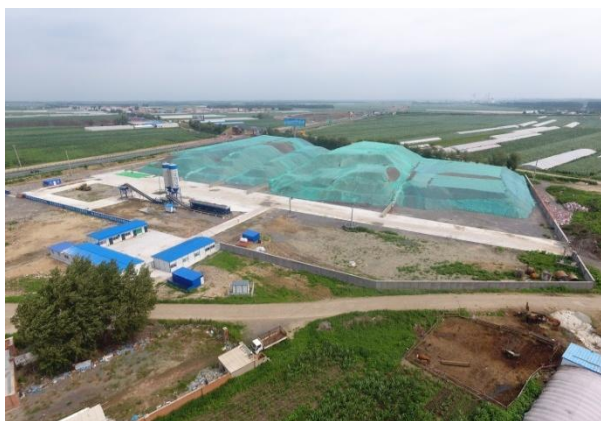
2018 年 7 月 7 工区拌合站
