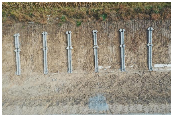
挖方边坡叠拱护坡（2019年9月）
