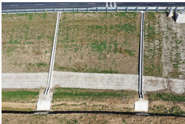
2019 年 9 月植草护坡+急流槽+土质边沟
