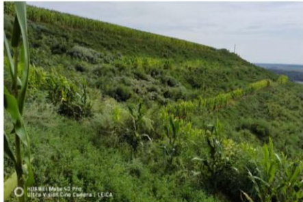
K1081+800 右侧张家沟取土场
