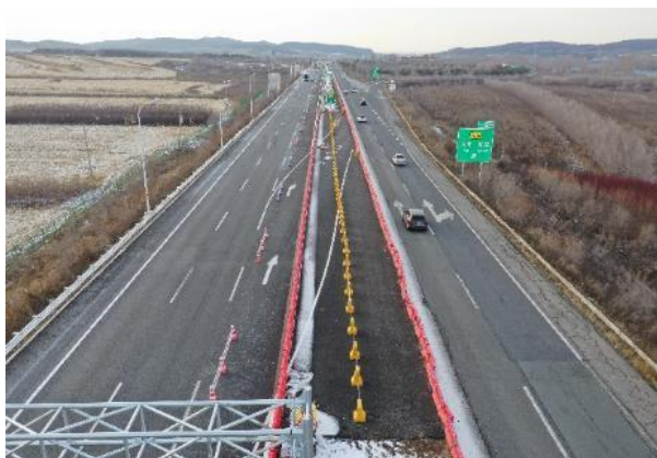
2018 年 11 月路基工程区
