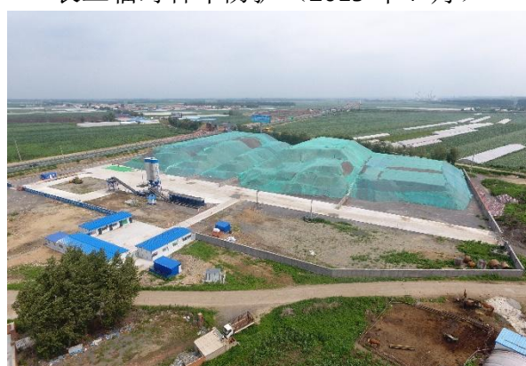
施工生产生活区临时苫盖（2018年7月）
