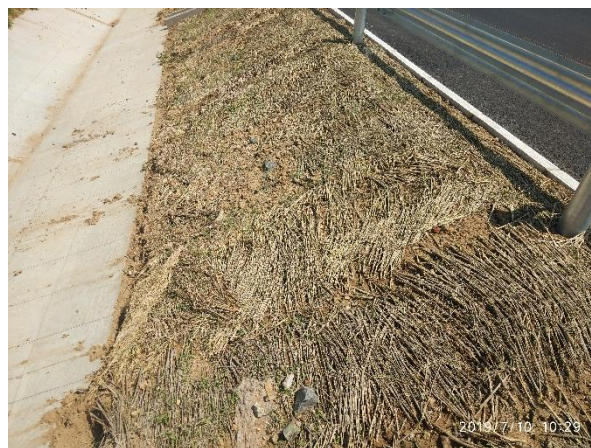
边坡临时苫盖 (2019 年 7 月)
