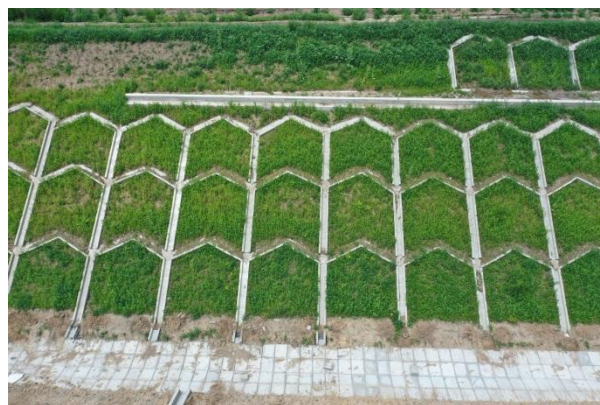
叠拱护坡+浅碟型排水沟（2019年7月）
