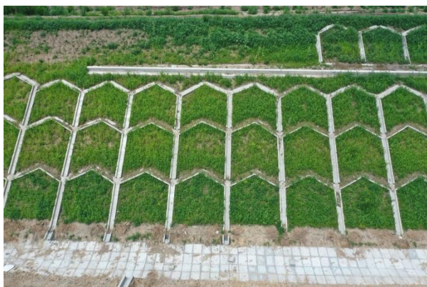
2019 年 6 月叠拱护坡+浅碟型排水沟
