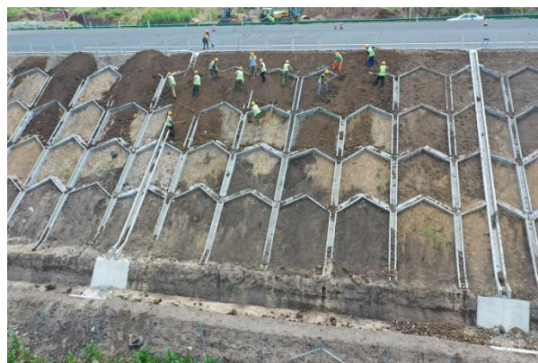
2019 年 6 月叠拱覆土施工
