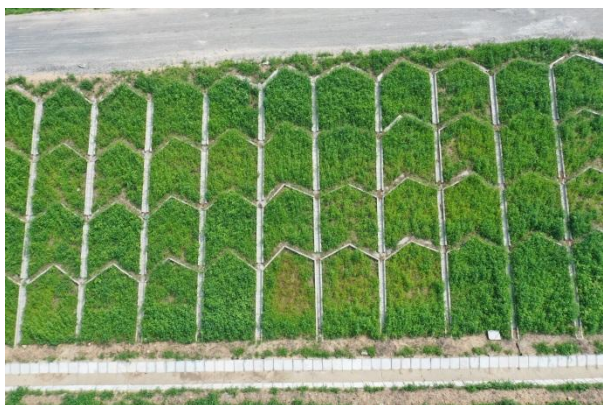
叠拱护坡+梯形排水沟（2019年7月）
