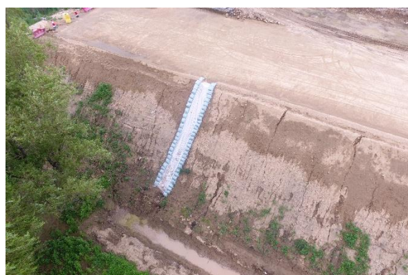
路基临时泄水槽（2018年7月）
