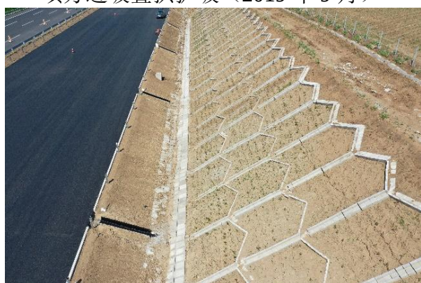
路堑 叠拱护坡+排水沟（2020年5月）
