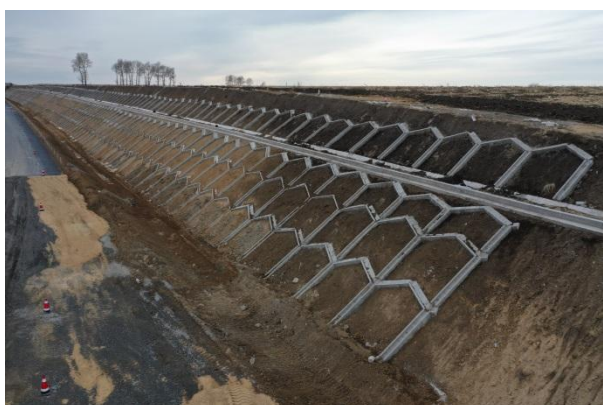
叠拱护坡（2018 年 11 月）
