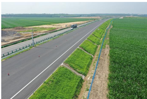
急流槽+排水沟及植草护坡（2019年7月）
