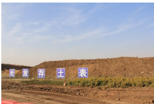
2018年5月表土剥离及临时防护
