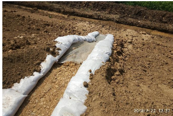
路基临时泄水槽 (2018 年 7 月)
