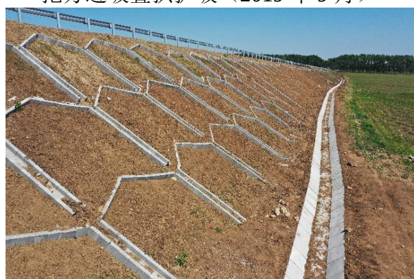
路基 叠拱护坡+排水沟（2020年5月）
