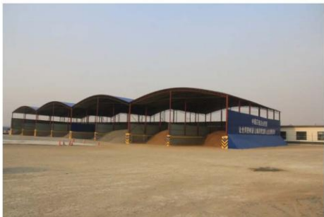
四工区拌合站
