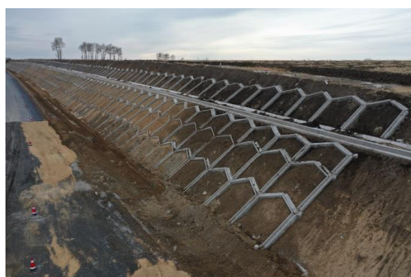
2018 年 11 月叠拱护坡开始施工
