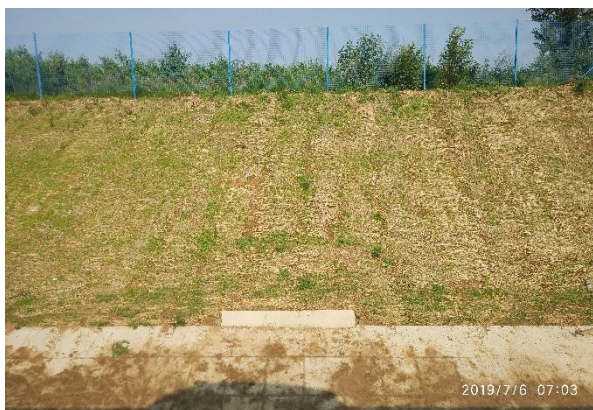
路堑边坡临时苫盖（2019年7月）
