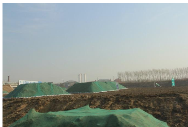
2018年4月表土剥离及临时防护
