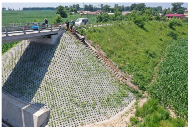
2019 年 6 月锥坡防护及植草护坡
