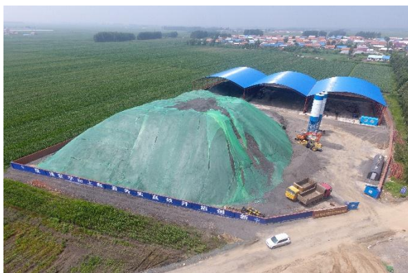
施工生产生活区临时苫盖 (2018 年 7 月)
