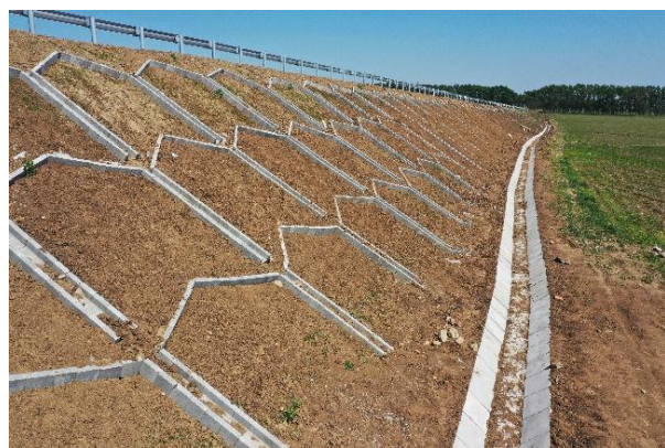
2020 年 5 月填方边坡 叠拱护坡+排水沟
