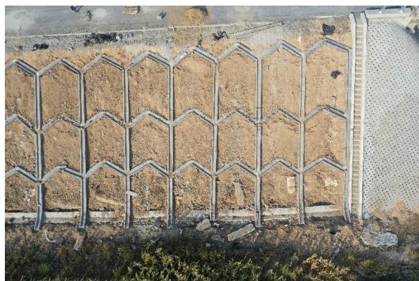
填方边坡叠拱护坡（2019年9月）
