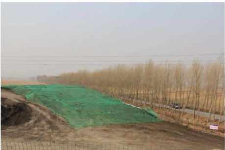
七工区表土临时堆放场
