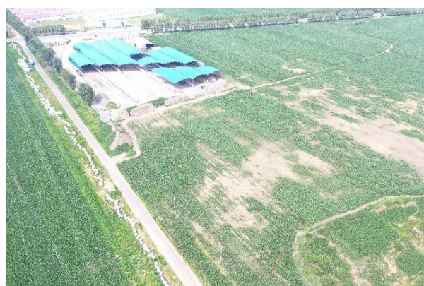
2021 年 7 月 8 工区沥青拌合站
